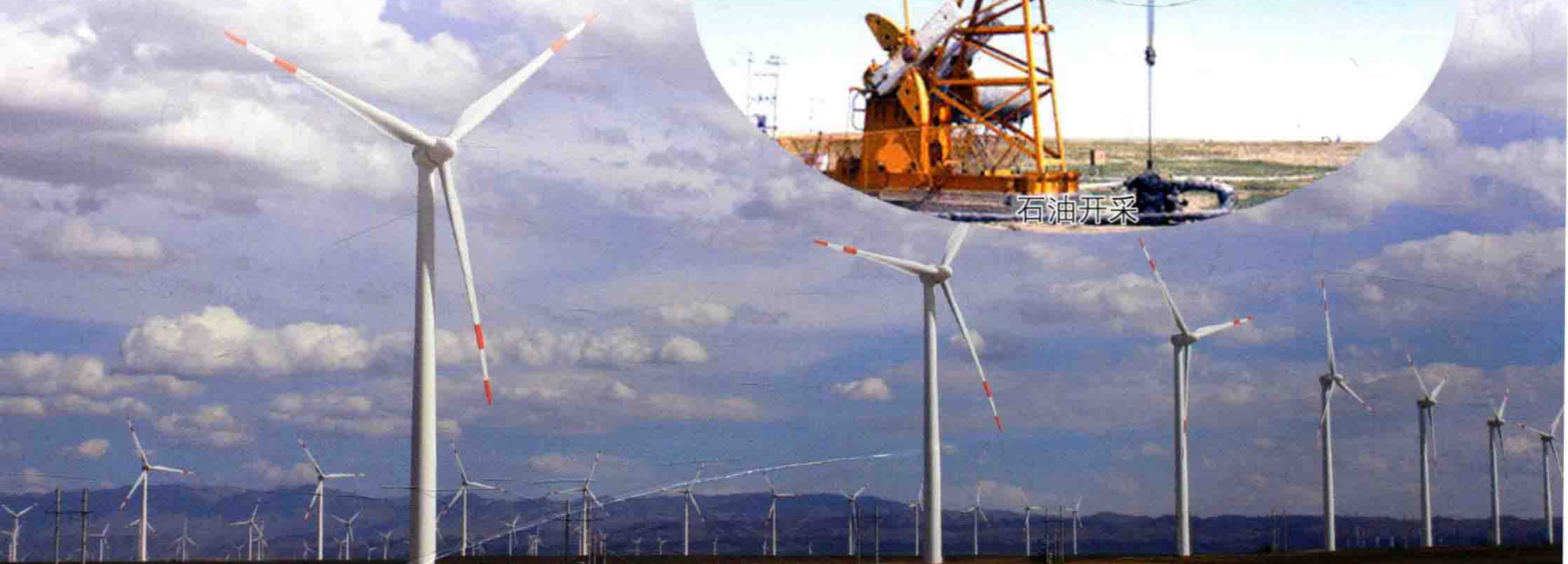
2010年,巴里坤三塘湖风力发电设备开始运行发电
