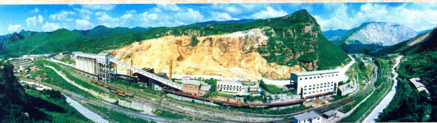
矿石破碎系统
