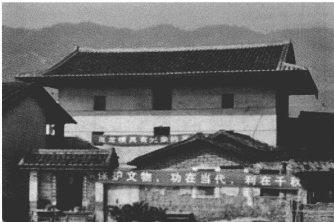
红色交通线永定高陂交通小站旧址：茂龙楼
