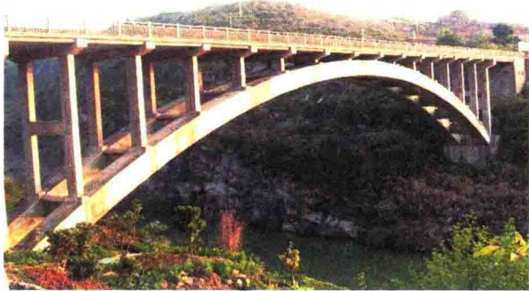
■ 山区拱桥实景
