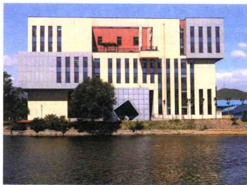
图5_河北省建筑科技研发中心办公楼
