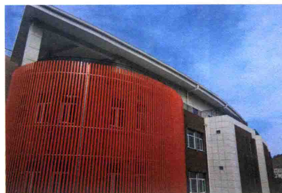
图13_威海市中小学生综合实践教育中心二号主题教育馆
