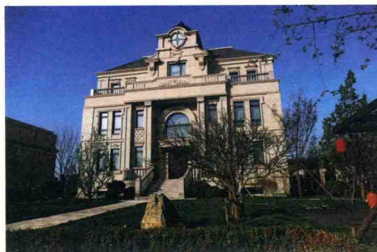
图11_大连金纬度项目1号楼
