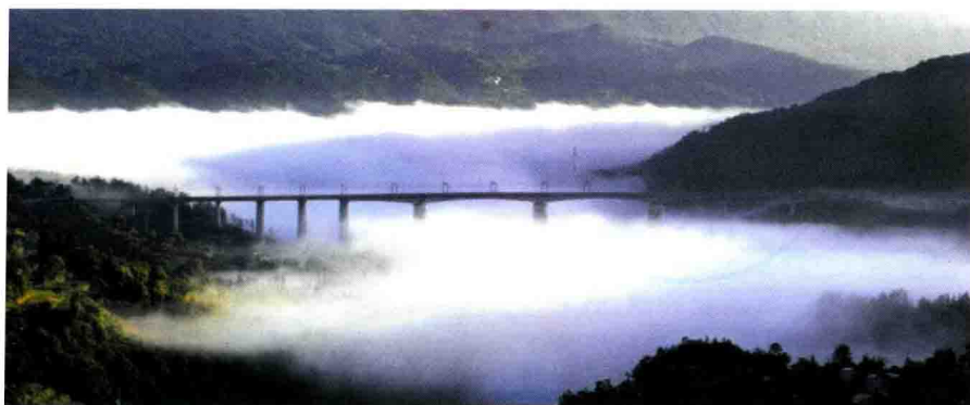
图0-5 恩施高速公路高架桥
