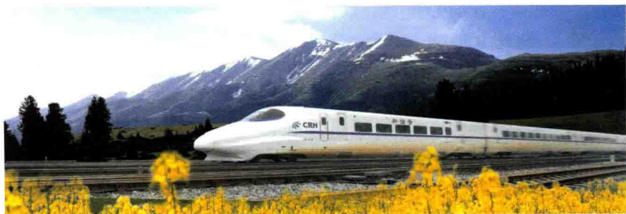
图0-4 恩施高速铁路
