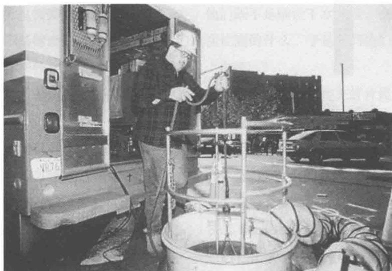
图1 信息高速公路入地：电话工人铺设光纤电缆。
