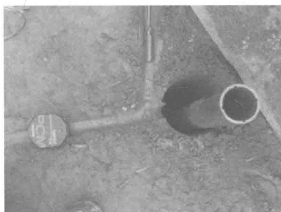
图 1-3 测斜管安装示意图
