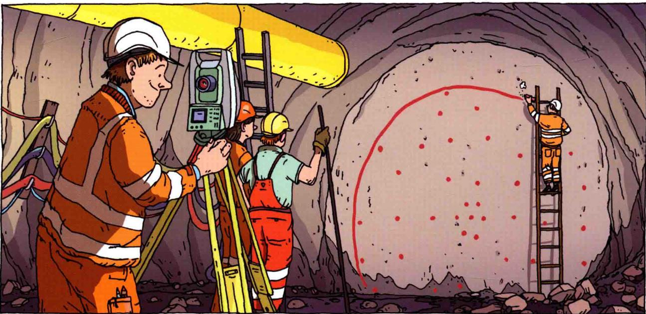
在用钻爆法施工的过程中，工程测量员要随时测量，以确保隧道在山体中不偏离预先设定的方向。隧道轮廓线和炮眼要预先标记。
