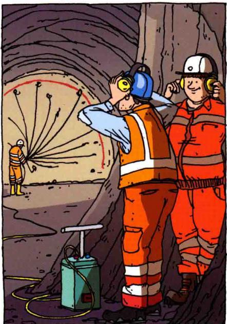
工人将炸药填充到炮眼里。随后，他们退到安全的地方，戴上隔音耳罩以保护听力。
