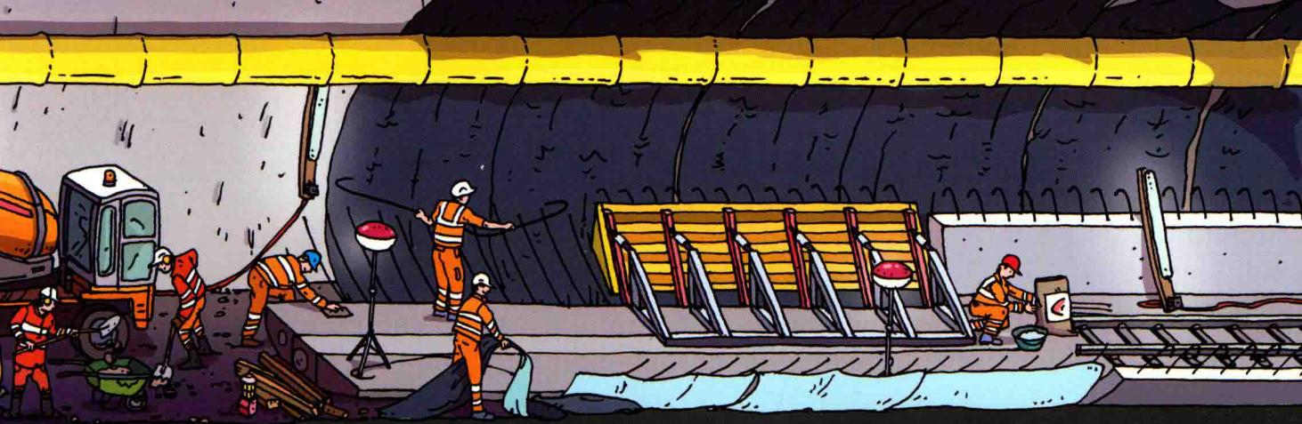
喷射混凝土后，工人们安装塑料防水板，它能将山体中渗出的水引入排水沟。隧道底部要用混凝土浇筑。
