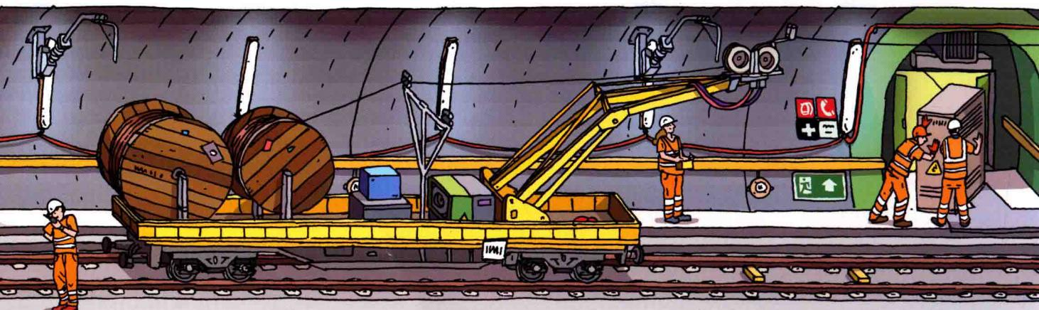
用来悬挂接触线的承力索被运进来了。隧道中还安装了一些其他设备，比如隧道风机和空调。
