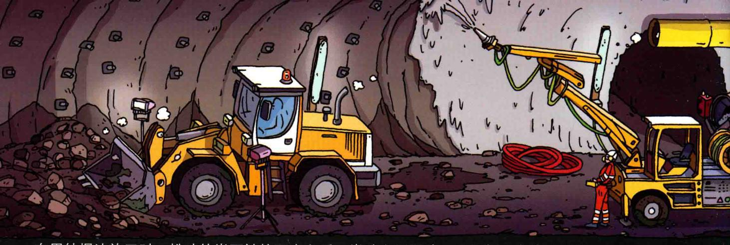
在用钻爆法施工时，松动的岩石被挖下来之后，岩壁上还要喷一层混凝土来防止坍塌。
