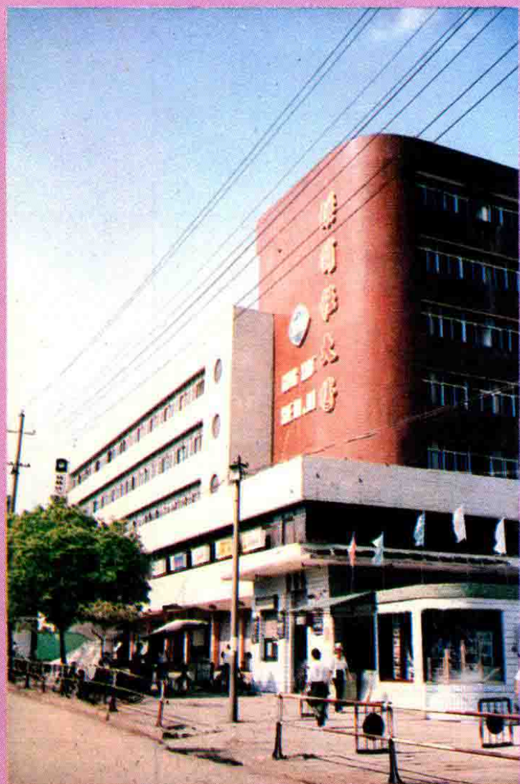
宜春市供销大楼
