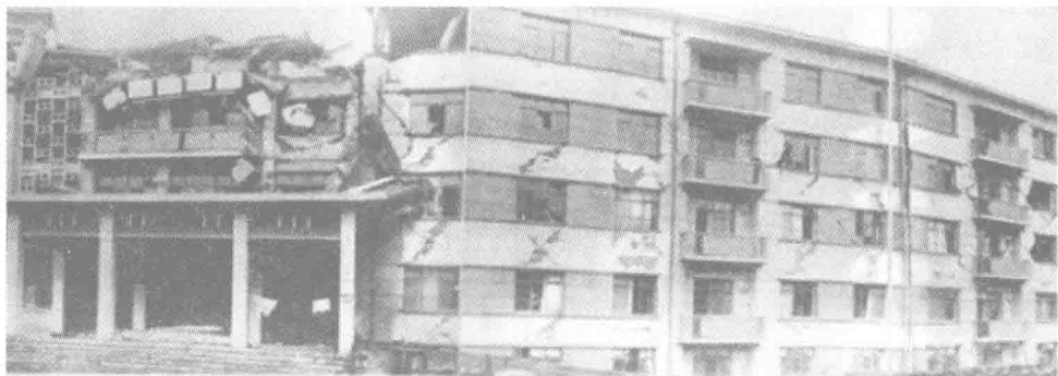
图 1-4 唐山大地震房屋破坏照片(1976年7月唐山地震照片集)
