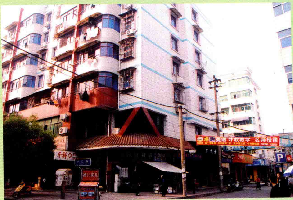
高安市二轻工业协会办 公室办公大楼
