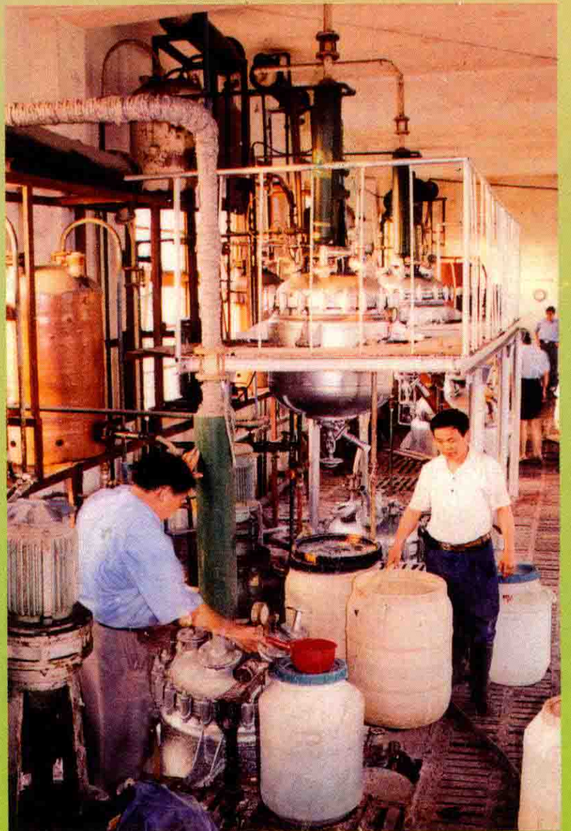
原第三化工厂生产车间
