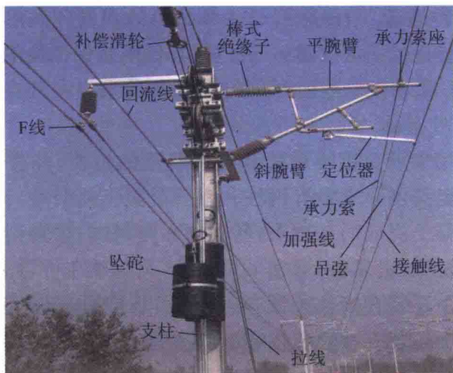
图 1-4 接触网结构示意图
