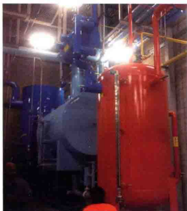
图 8 低温低压循环桶（浅蓝色）与中温低压循环桶（深蓝色）的安装现场 （Lineage 公司，2014 年完工，美国）
