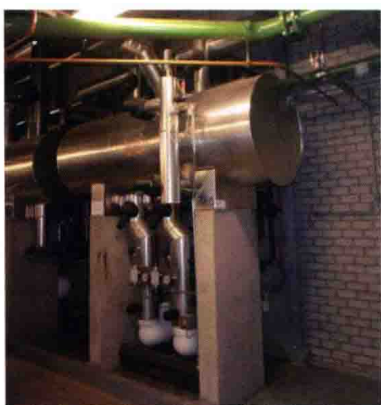
图 11 采用二次节流供液方式，制冷液体在进入其中一台中温低压循环桶液体节流后，再向另一台低温低压循环桶进行二次节流供液（Diepop's-Hertogenbosch B. V，欧洲）
