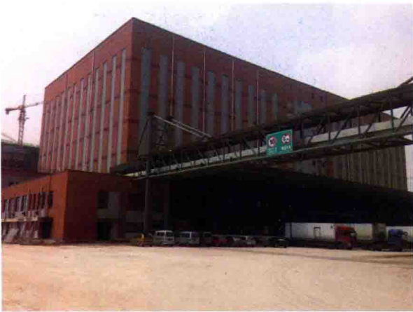
图3 2012年完工的山东中凯兴业贸易广场有限公司15万吨冷库
