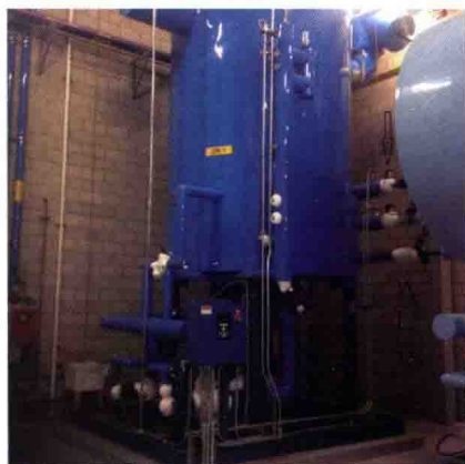
图 9 低温低压循环桶（浅蓝色）与中温低压循环桶（深蓝色）的一次节流供液（向下箭头）与二次节流供液（向上箭头） （Lineage 公司，2014 年完工，美国）
