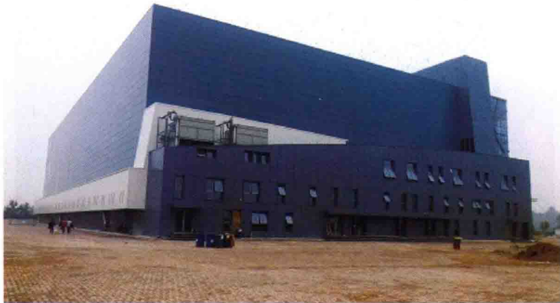
图2 2013年完工的北京京津港冷链物流冷库的外形
