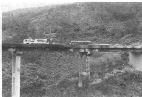
图 1-8 福银高速公路闽清建新大桥火灾
