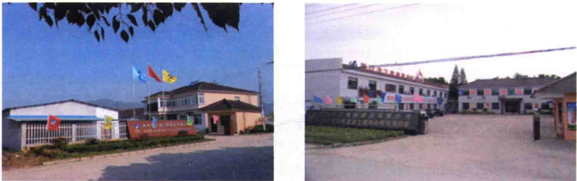
图1 驻地租用民房和厂房实例
