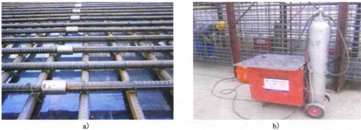
图 18 螺纹套筒连接及二氧化碳保护焊设备实例
