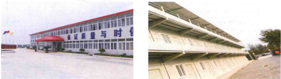
图 4 彩钢板、集装箱驻地实例
