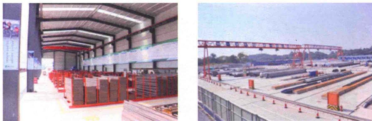
图7 钢筋加工厂和梁板预制厂实例
