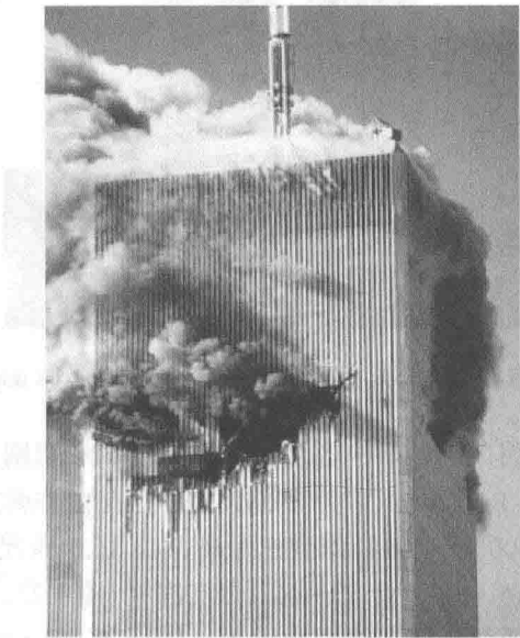
图 1.3 世贸大厦双子塔 1 号楼北侧撞击局部 (Thierry, 2002)
