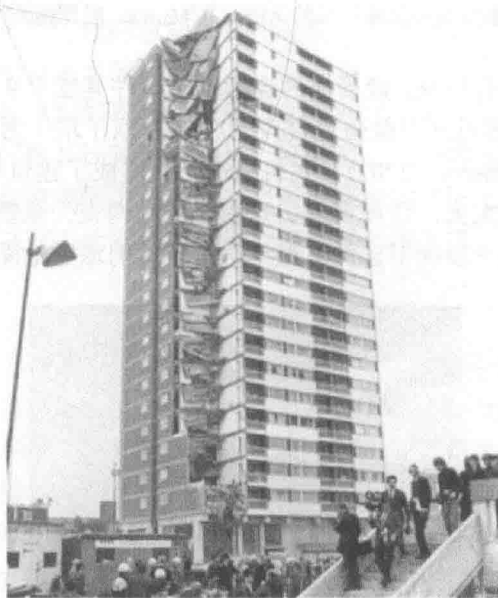
图 1.1 1968 年 5 月局部坍塌后的 Ronan Point 公寓大厦(Wikipedia, 2012)
