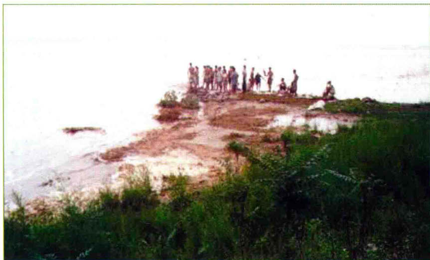
漳河陈村6号坝被洪水冲刷
