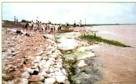
漳卫新河无棣段堤防加固
