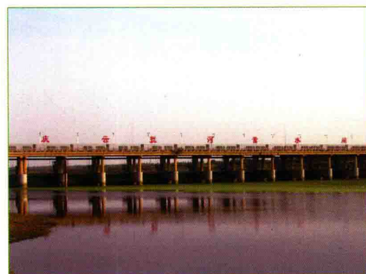
庆云拦河蓄水闸
