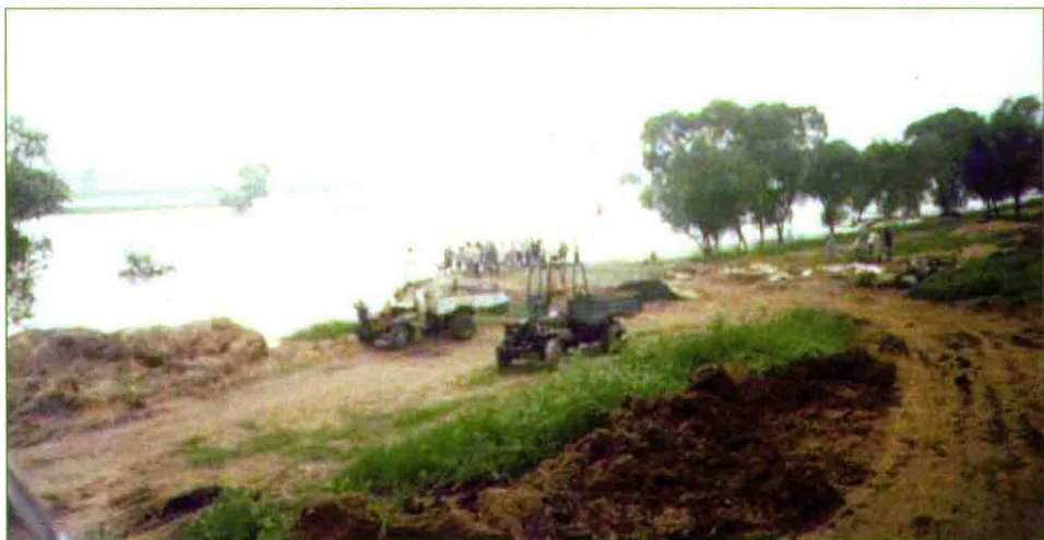
卫运河北大洼封堵现场
