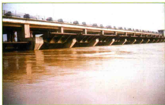
漳卫新河庆云拦河蓄水闸过水场景
