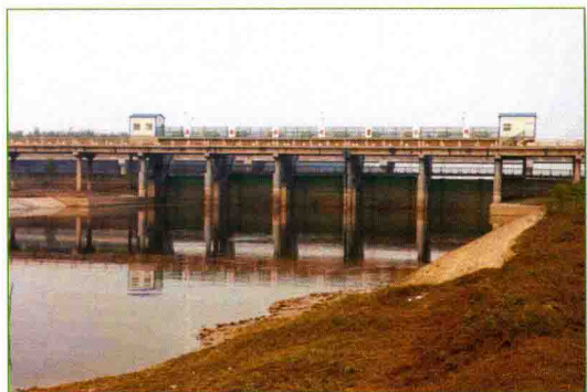
袁桥拦河蓄水闸
