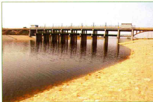
吴桥拦河蓄水闸
