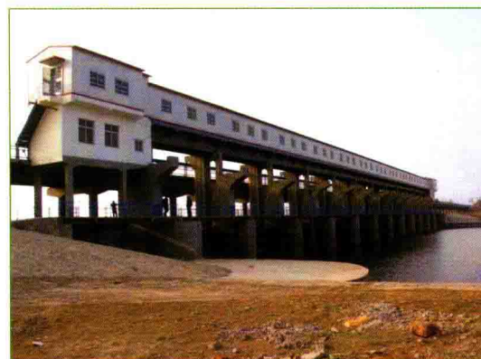
辛集挡潮蓄水闸
