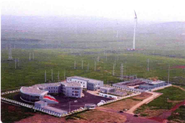
图 1 新能源与储能运行控制国家重点实验室
