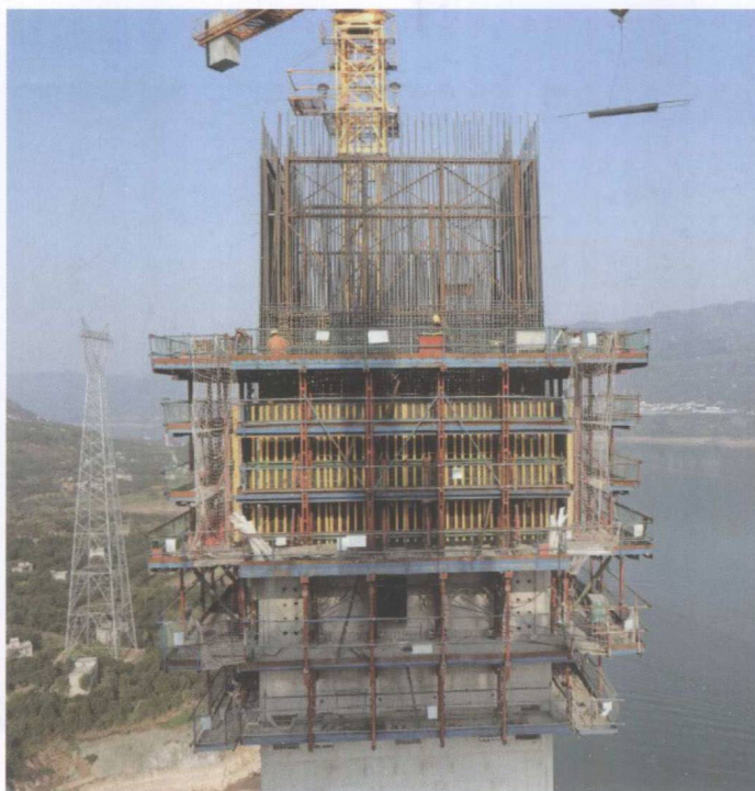
驸马长江大桥索塔液压爬模施工
