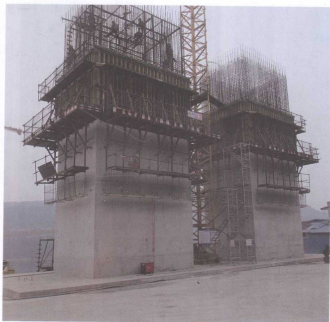
提模（悬臂模板）施工
