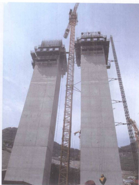
提模（悬臂模板）施工效果
