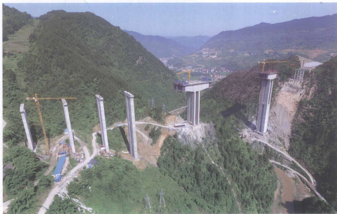
龙驹特大桥滑模施工效果
