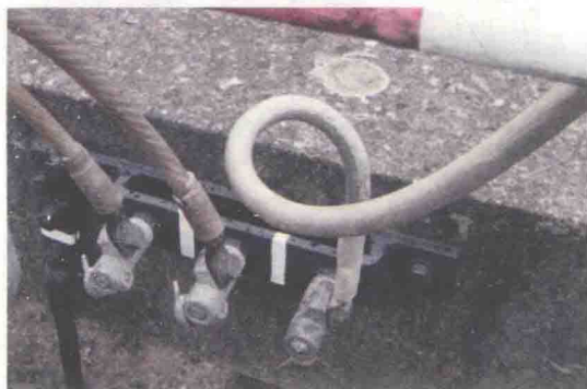
图 1-9 三相合一的接地端子
