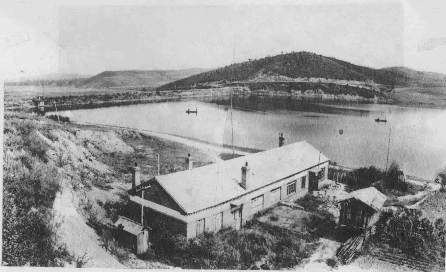
新发乡东升小（一）型水库全景
