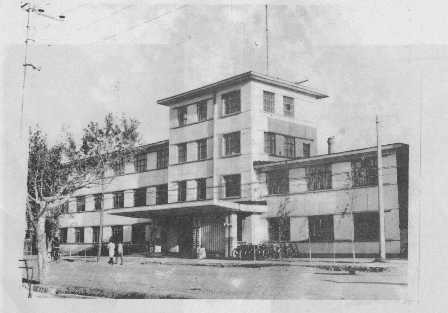
柳河县水利局办公楼
