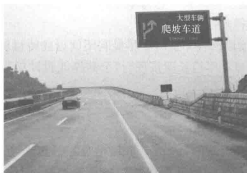
图 2-2 利用硬路肩的爬坡车道 注:图片来自网络。
