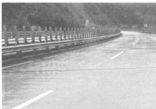
图 2-13 超高段路面积水照片 注:图片来自网络。
