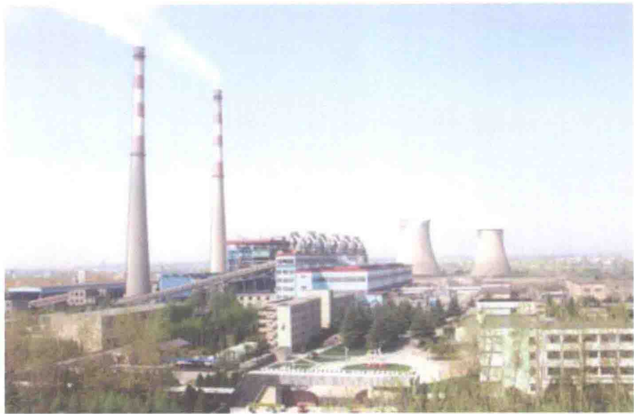
中石化仪征化纤热电锅炉低氮燃烧项目
