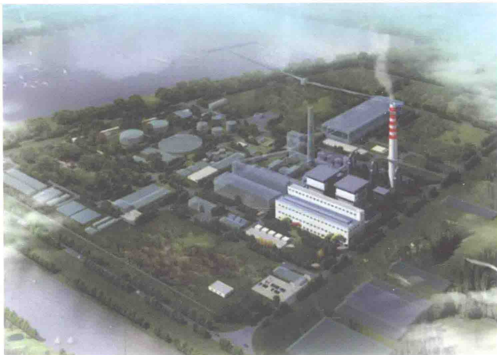
新浦化学(泰兴)有限公司热电项目 ( 3 \times 140 t/h 高温高压 CFB 炉+ 2 \times \text{CB50} )
