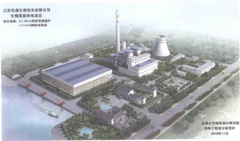
江苏华晟生物发电有限公司(江苏省优秀工程咨询一等奖) (2×75 t/h straw incinerators+2×C15 MW)
