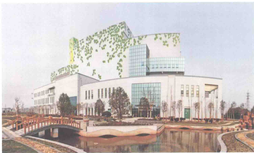
江苏天楹环保海安垃圾发电厂 ( 3 \times 250 t/d 比利时 WTL 公司炉排炉+ 2 \times \text{N7.5 MW} )
