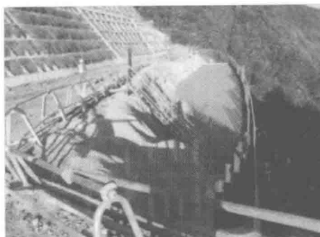
图 2-7 坍塌路基现浇泡沫轻质土施工图
