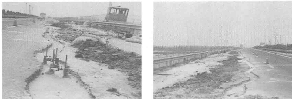
图 2-4 路基注浆加固
