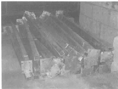
图 2-7 屏蔽门立柱
