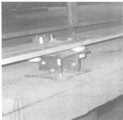
图 2-4 屏蔽门底部支撑部件与站台板螺栓连接形式 图 2-5 上部连接部件与站台顶梁连接形式
