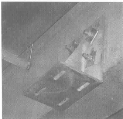
图 2-4 屏蔽门底部支撑部件与站台板螺栓连接形式 图 2-5 上部连接部件与站台顶梁连接形式
