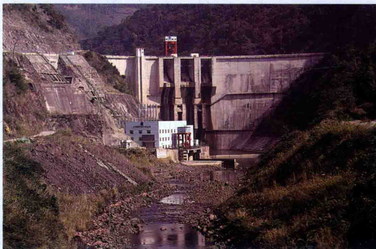
云南省宁洱哈尼族彝族自治县重点水利工程——石门坎水电站。
