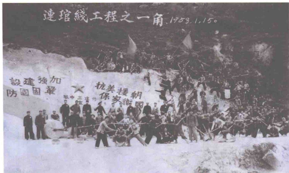
解放后，连江县为加强海防斗争、改善群众生活和交通条件，致力于交通运输建设。图为连江公路建设现场一角。
