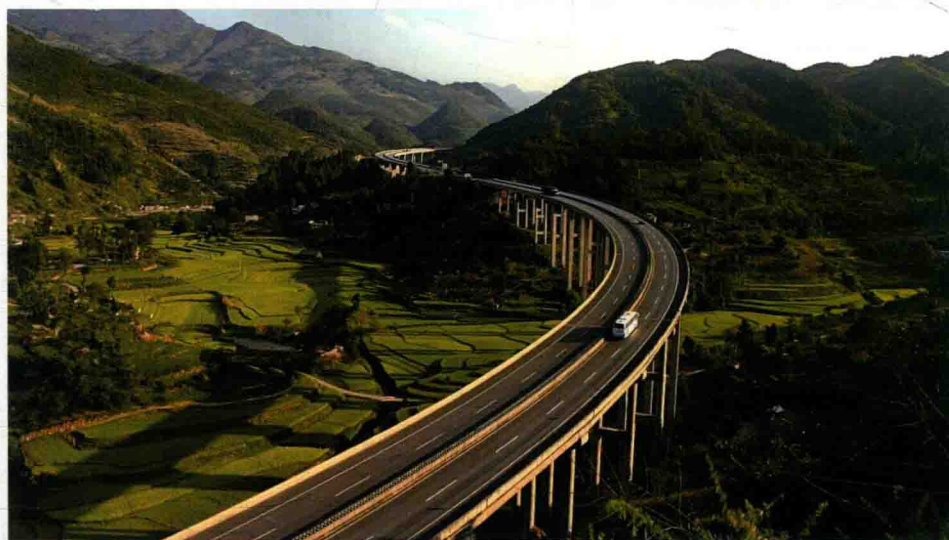
崇溪河至遵义高速公路姜家坝大桥建成通车。
