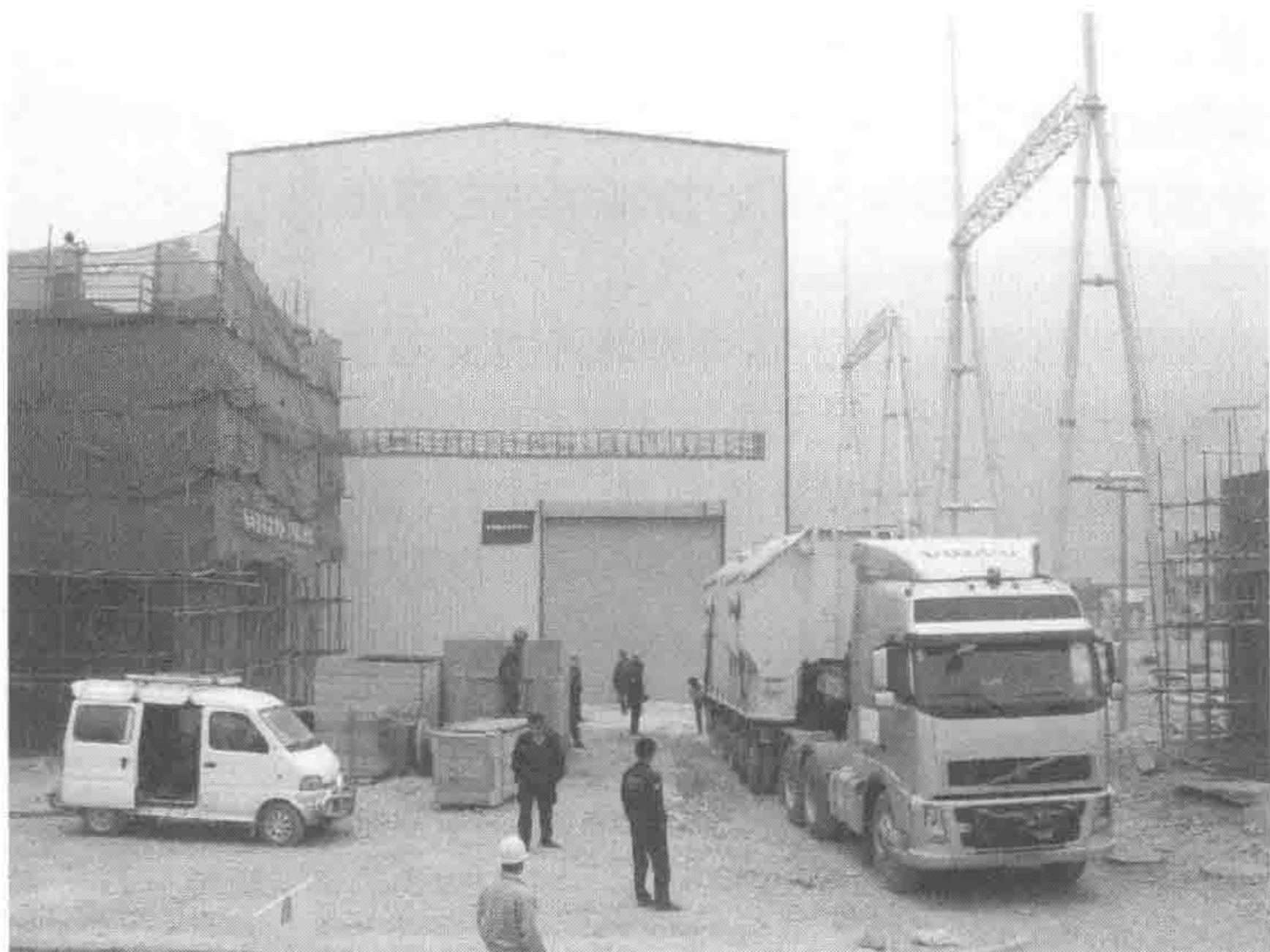
图 1-11 现场安装厂房
