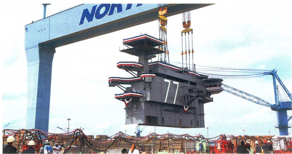
“布什”号“岛”式上层建筑模块吊装
