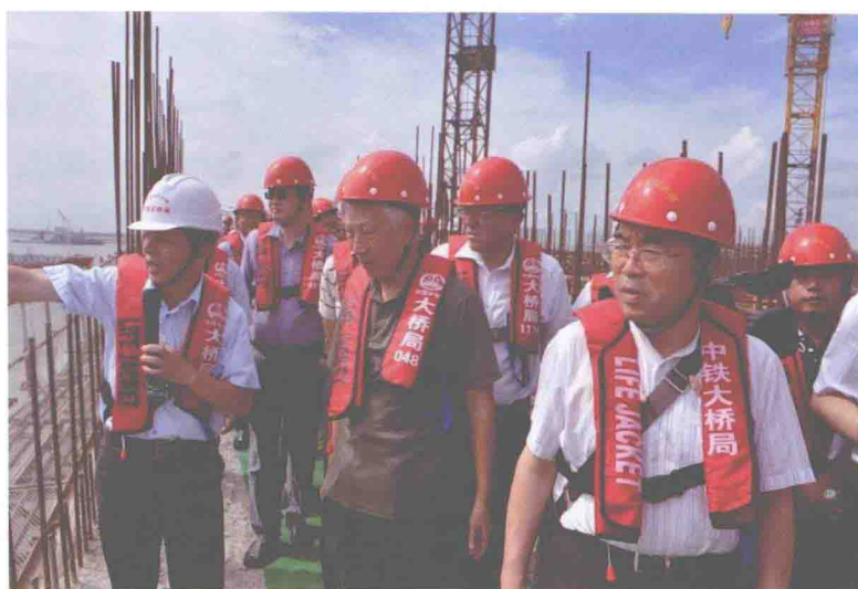
“交通基础设施重大结构安全保障战略研究”项目组的部分院士专家考察在建的沪通长江大桥
