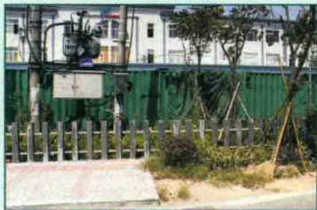
(3) 接头安装棚搭设完成。
