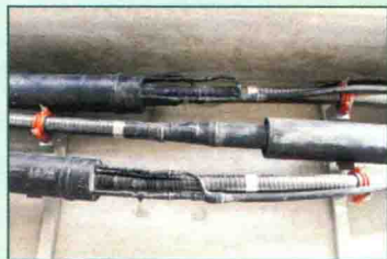
(5) 确定中间接头摆放方式，即中间接头的中心点。
