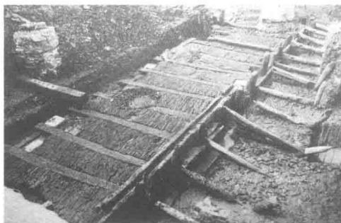
唐木构建筑遗址
