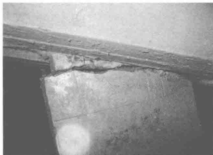
图 1-2 船舶撞击造成基桩桩顶断裂
