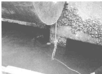
图 1-4 潜水人员进行水下基桩损伤检测
