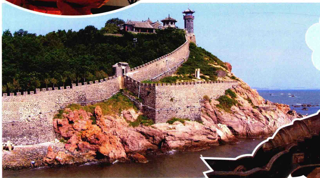
▼修复后的水城城墙。
