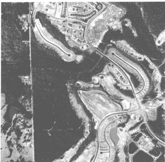
位于桃树街的太阳城，一个占地 1726 英亩（698 公顷）的老年社区正在建设中。美国佐治亚州亚特兰大市以南 35 英里（56 千米）
