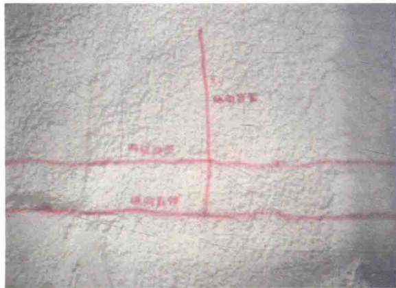
图 2.3-4 路面控制基线
