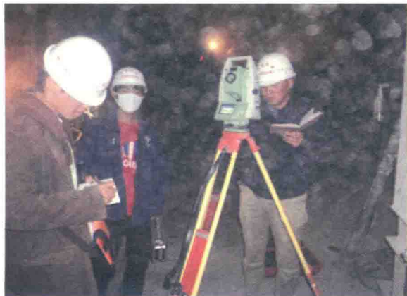
图 2.3-3 仰拱测量放线
