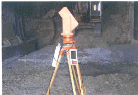
图 2.2-1 隧道防水层施工前断面检测
