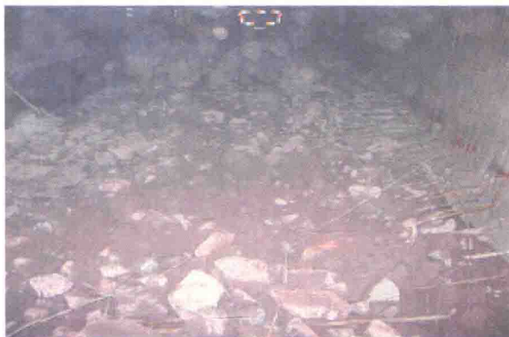
图 2.3-2 仰拱回填片石不规范导致质量差
