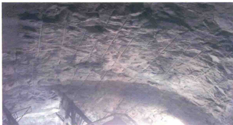
图 2.1-1 光面爆破效果
