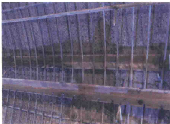
图 2.3-8 仰拱钢筋定位角钢
