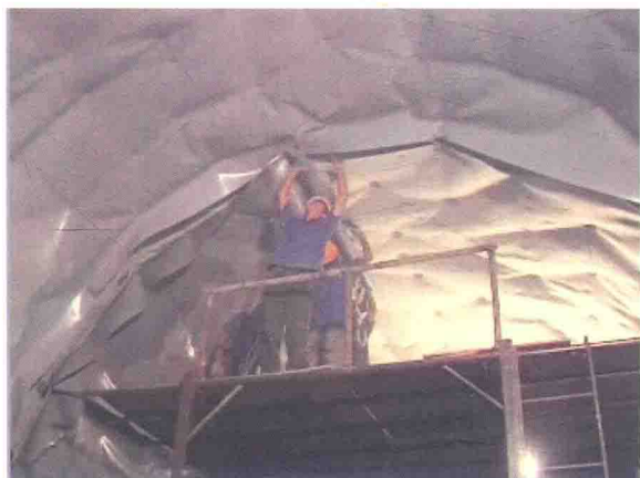
图 2.1-9 隧道防水板施工图
