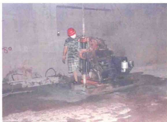
图 2.3-9 仰拱钻孔取芯图
