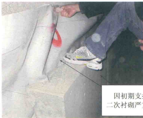
图 2.2-2 隧道初期支护侵入二次衬砌界限
