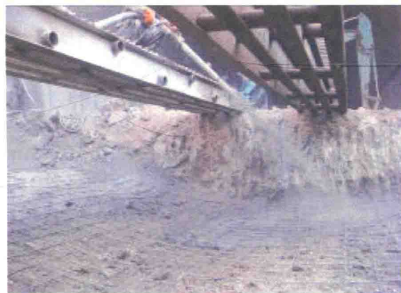
图 2.3-6 施工质量较好的仰拱
