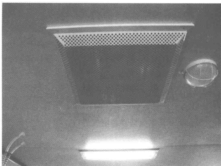
图 0-2 SPF 家兔饲养场空气过滤风口 (青岛康大生物科技有限公司 姜浩提供)
