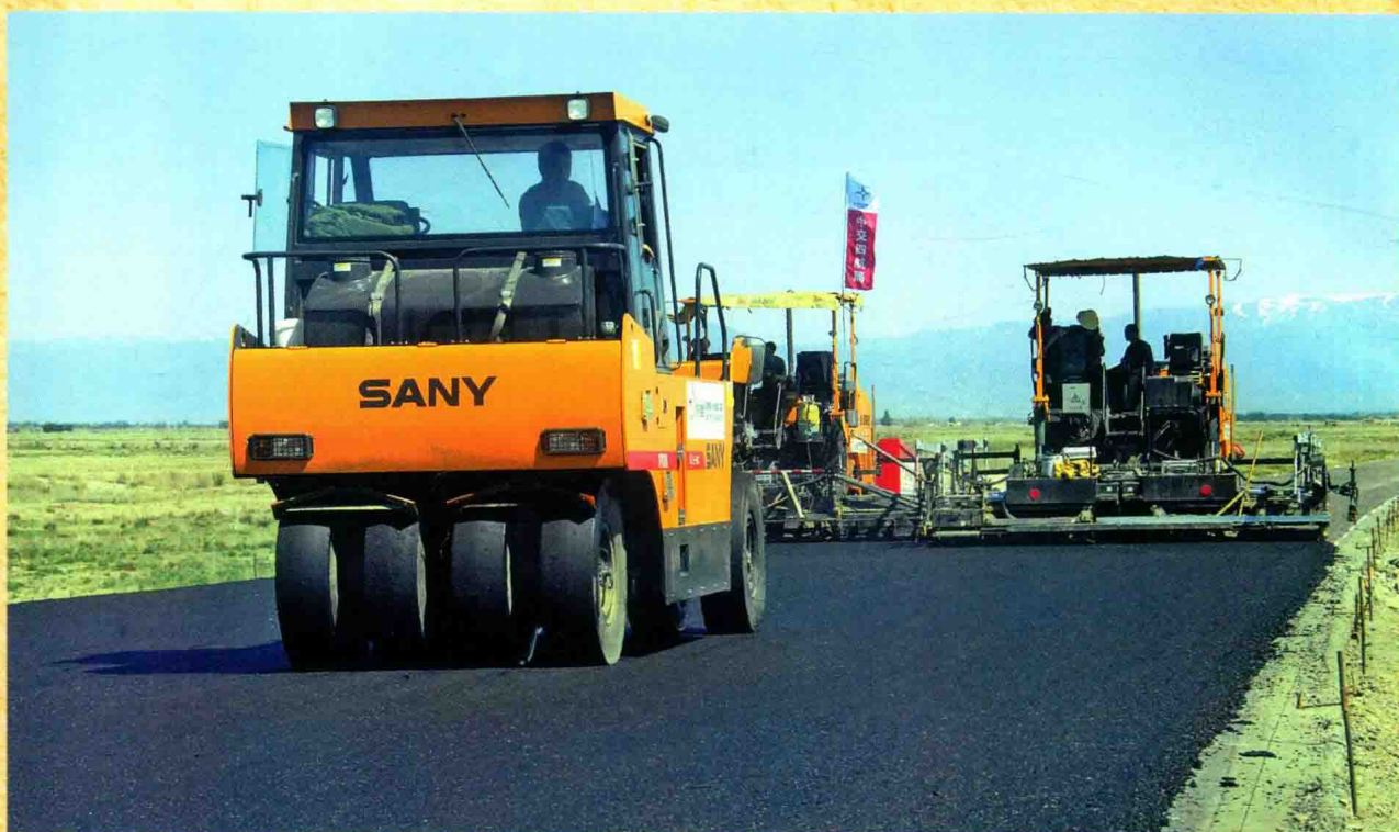
2013年5月15日，克塔高速进入铺油阶段。图为中交四航局克塔高速KT-3标项目经理部工作人员在碾压沥青路面。
