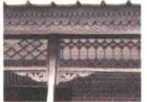
修复后的“仁和永”内院外立面装饰
