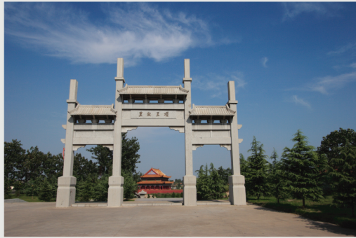
▲ 项王故里石牌坊 1999年12月建成。青石质，仿汉风格，三门四柱冲天式，歇山顶。高11.5米，面阔13米。
