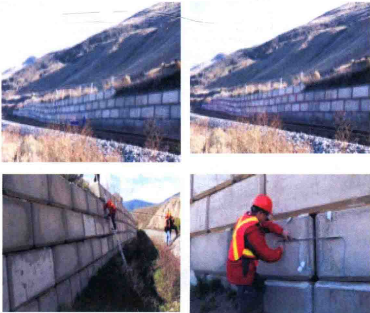
图 6 加拿大里普利滑坡光纤传感器安装现场
