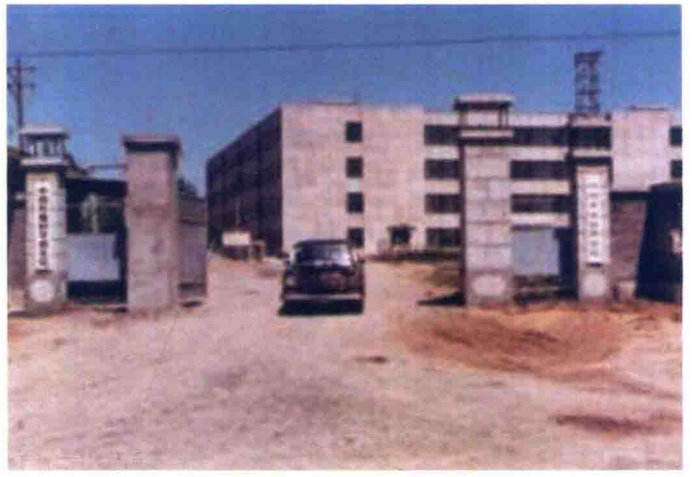
中国环境科学研究院和中国监测总站建设初期，建设中的实验大楼（20世纪80年代初）
