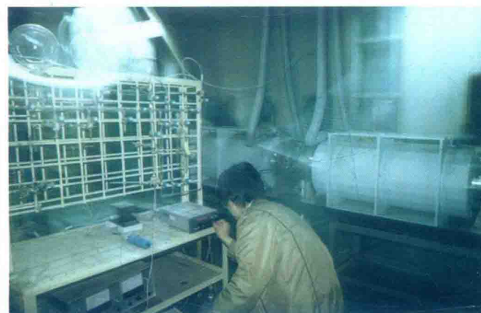
中国环境科学研究院建设的可抽真空、长光程 FTIR 烟雾箱，左配气系统，右反应器系统（1985）
