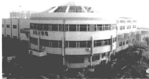
图 1-4 左安门 220kV 变电站
