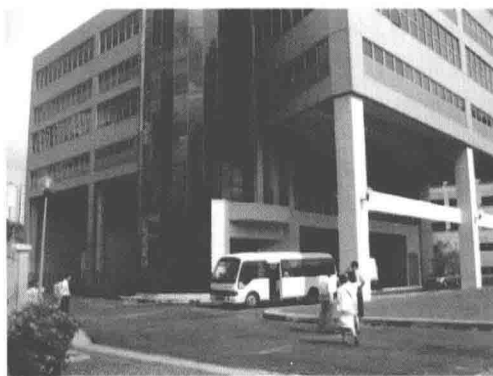
图 1-6 新加坡 275kV 变电站
