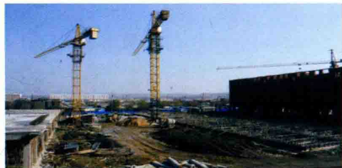
建设中的和乐家苑小区
