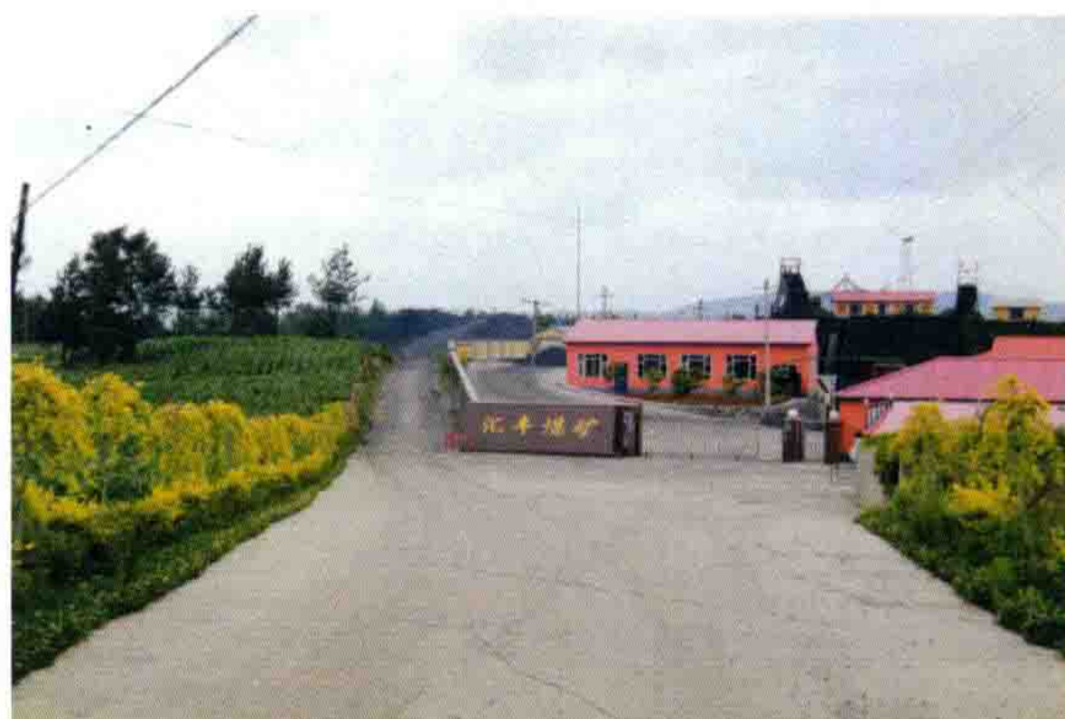
重点项目汇丰煤矿建设项目
