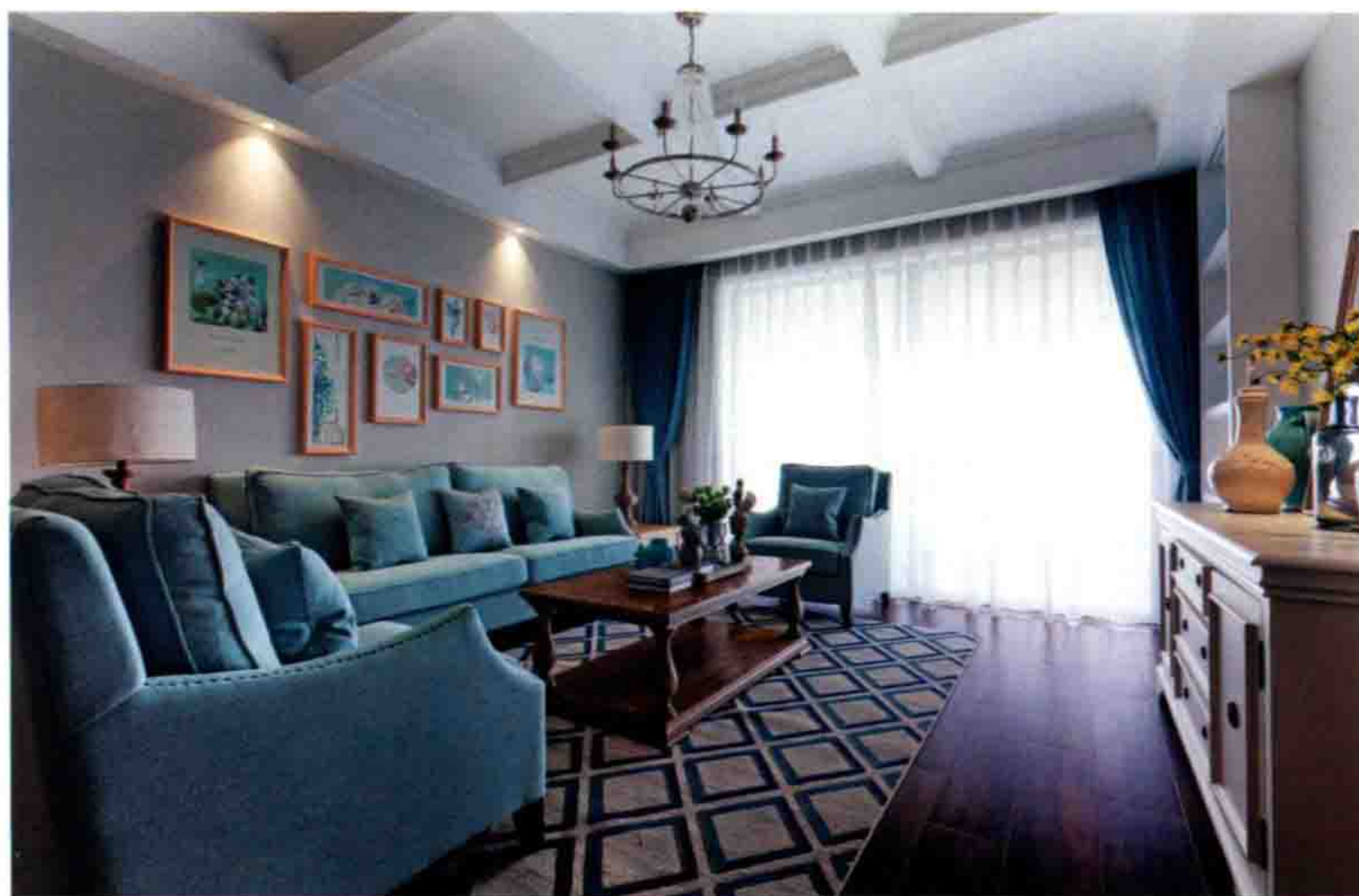
顶面 [ 石膏板装饰梁 ]
