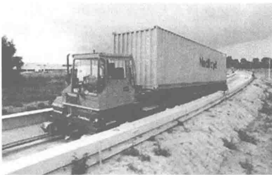
图 1-1 无人驾驶货车导轨
