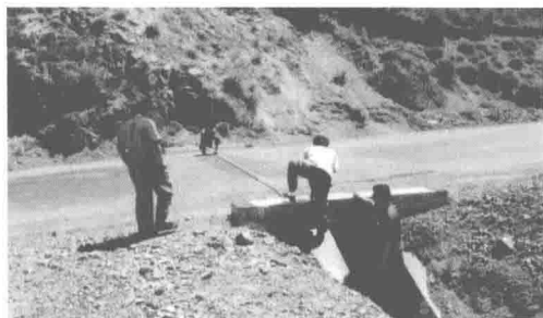
▲ 图 2-10 20 世纪 90 年代独山子段技术员拉着皮尺测量涵洞
