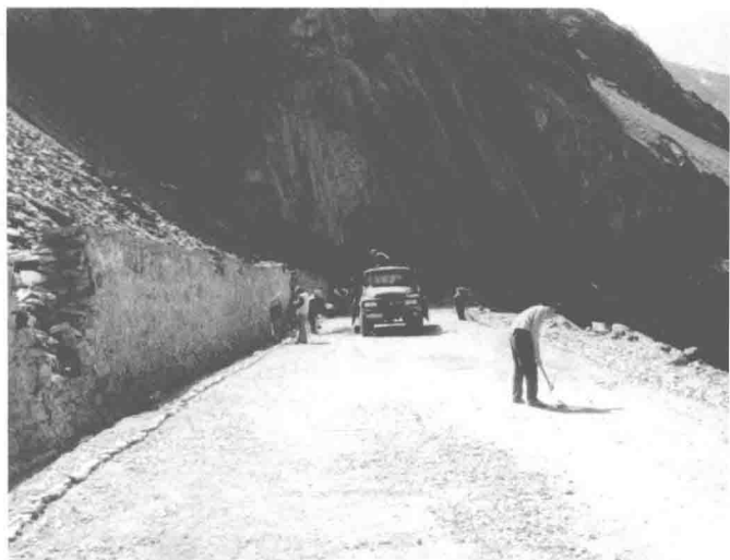
► 图 2-9 20 世纪 90 年代独山子段养护职工用东风车拉料养护砂砾路面
