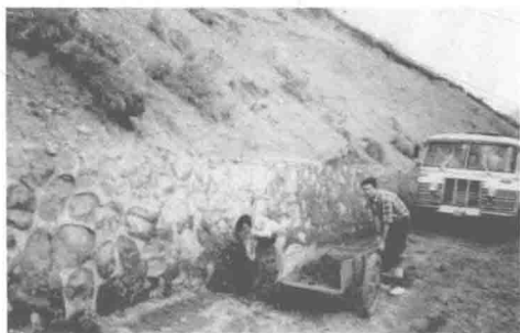
▲ 图 2-8 20 世纪 80 年代独山子段养护职工推着手推车拿着十字镐养护砂砾路面
