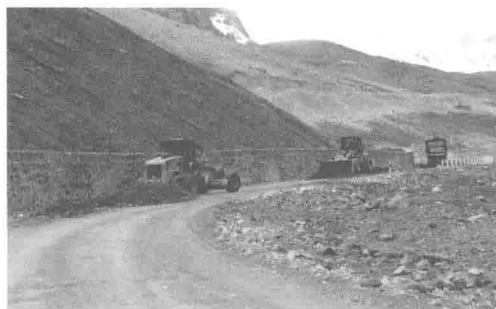
▲ 图 2-12 机械组合养护砂砾路面
