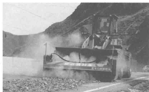
▲ 图 2-13 改造发明的碎石清扫车填补山区机械保洁的空白
