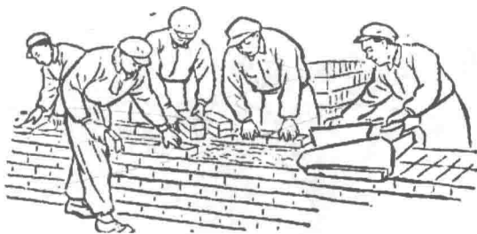
图5 苏长有小组的双手挤浆法。前面徒工推的是经过改良后的“坦克式铺灰器”
